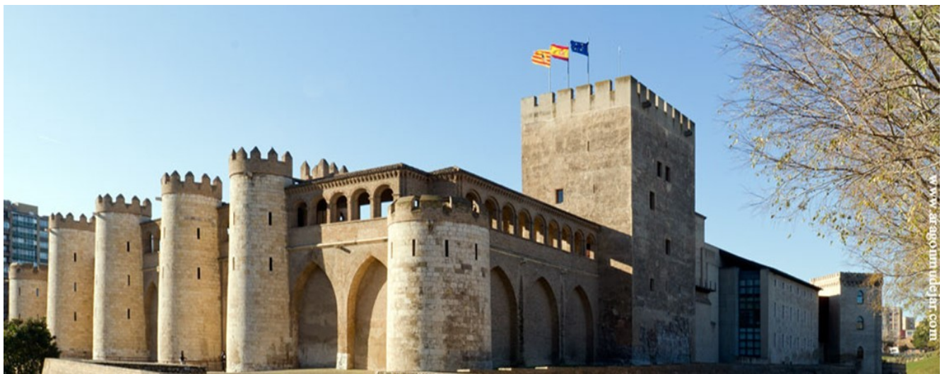
Palacio de la Aljafería
